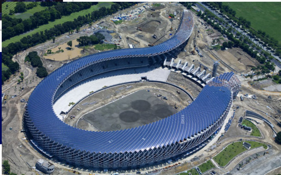
Lo stadio solare di Taiwan (inaugurato 2009) (design.:Toyo Ito) 14.155 m 2 , 8.844 pannelli solari.
